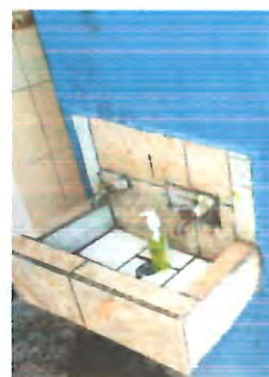
Foto 4: Reparación de lavamanos en mal estado, cambio de azulejo.
