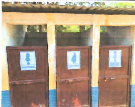
Foto 1: Suministro e instalación de puerta metálicas para sanitarios.
