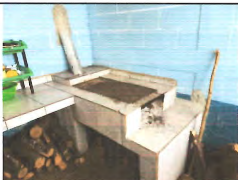
Foto 5: Sustitución de estufa rural con chimenea, plancha y accesorios.
