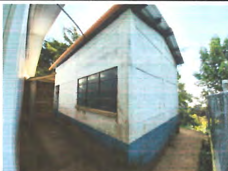
Foto 3: Preparación de la superficie y aplicación de pintura a dos manos, en paredes interiores y exteriores del establecimiento en área de cocina y sanitarios.
